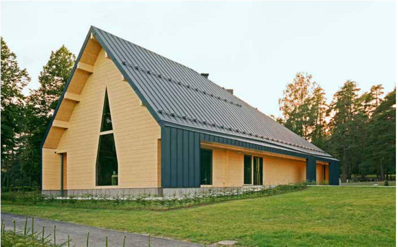
Friedhofskapelle in Vihti. Foto Honkarakenne Oyj.
