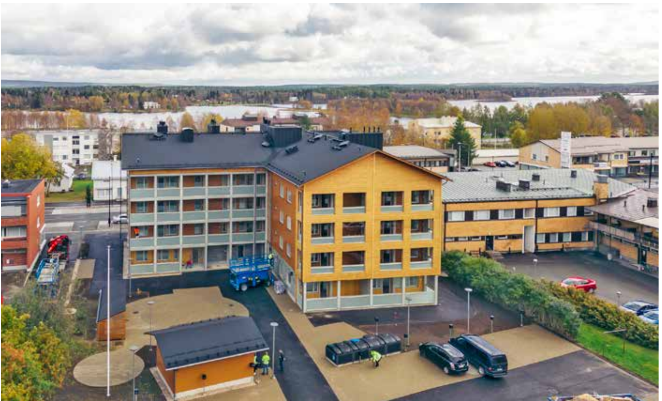
Mehrfamilienhaus aus Massivholz in Kuusamo. Foto Kuusamo Hirsitalot Oy / Jakke Murtovaara.
